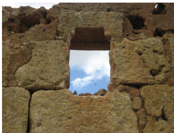
Foto 9.- Ventana en cabecera en muro este de la ermita.
