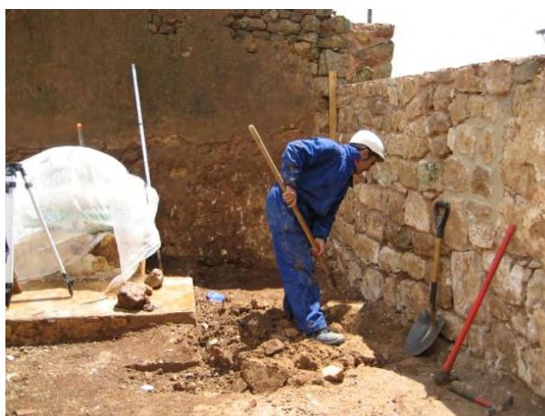
Foto 7.- Remociones de tierra realizadas en el interior.
