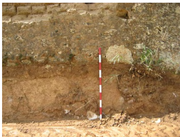
Foto 5.- Espesor de tierra eliminada junto a muro.
