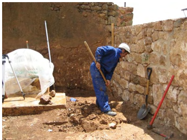
Foto 7.- Remociones de tierra realizadas en el interior.
