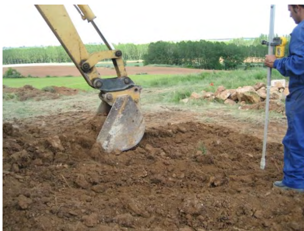
Foto 3.-Remoción de tierra, realizada en el exterior de la ermita, realizada con medios mecánicos.
